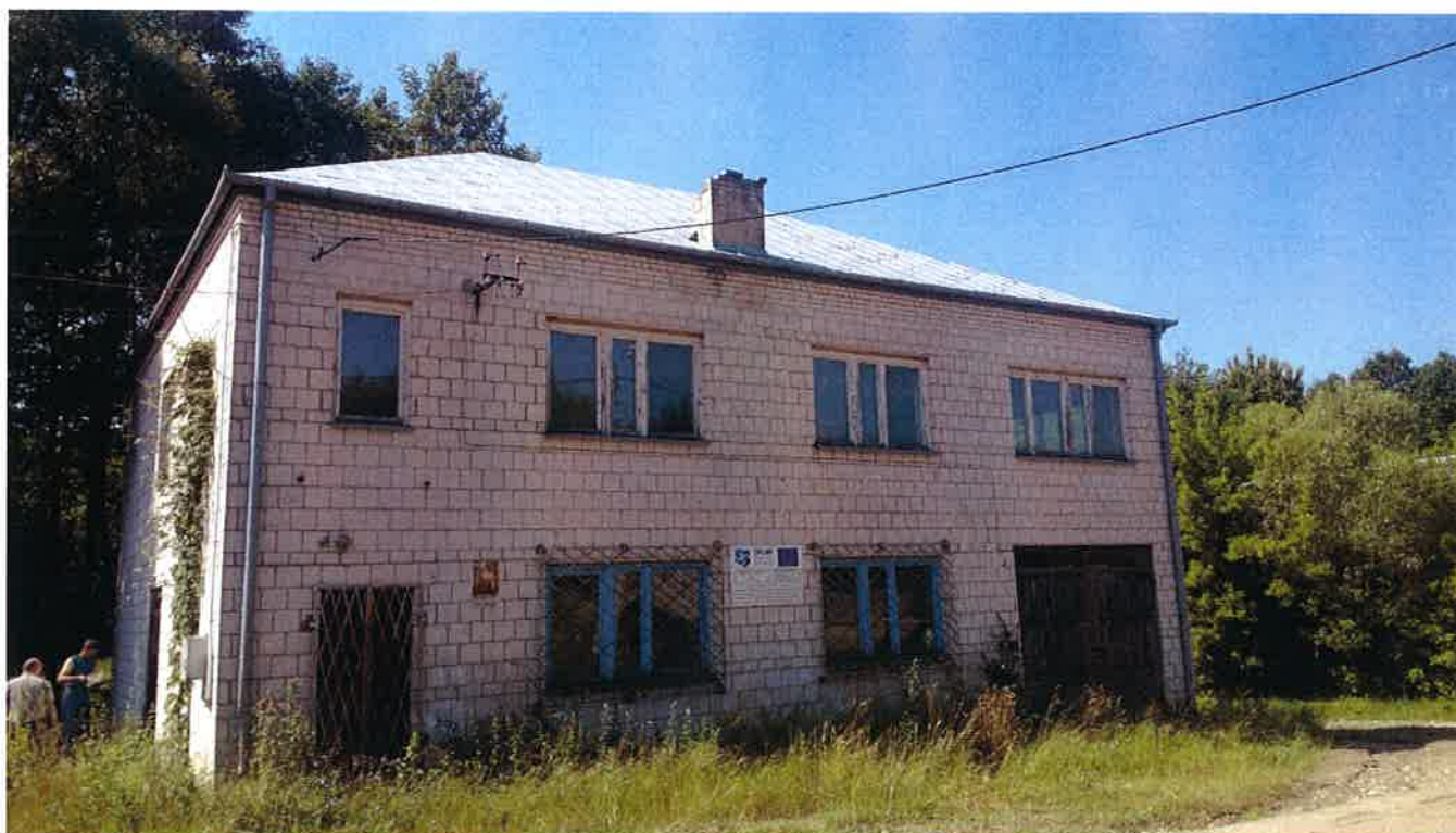
Zdj. 1. Budynek objęty opracowaniem
