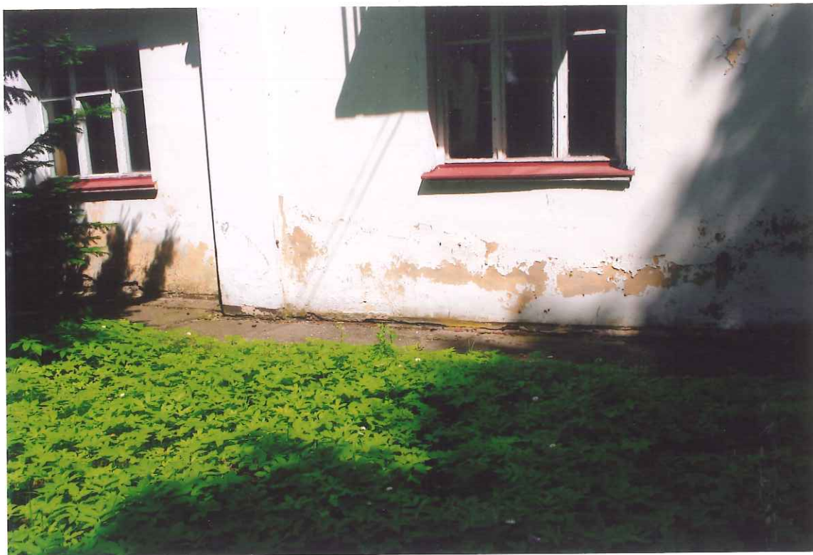
FOT. 8 DWÓR W GRABOWIE SKRZYDŁO WSCHODNIE. ELEWACJI POŁUDNIOWEJ , BETONOWA OPASKA I ŚLADY ZAWILGOCENÍ
