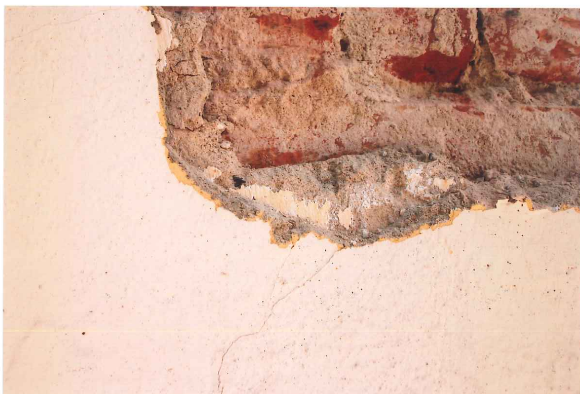
FOT. 31 DWÓR W GRABOWIE SKRZYDŁO WSCHODNIE , ODKRYWKA UKZUJE ORYGINALNY TYNK Z POBIAŁĄ I BŁADO UGROWĄ WARSTWĄ FARBY
