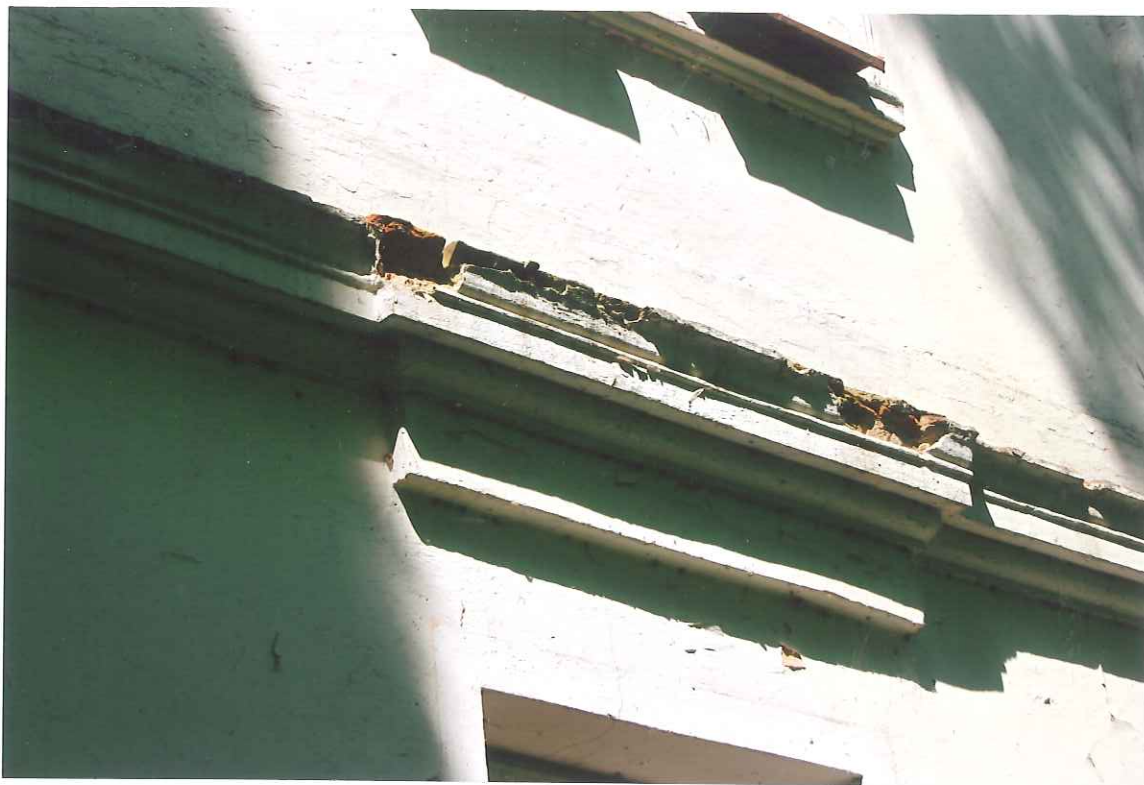
FOT. 24 DWÓR W GRABOWIE, SKRZYDŁO WSCHODNIE, USZKODZONY GZYMS FOT. 25 DWÓR W GRABOWIE SKRZYDŁO WSCHODNIE, FRAGMENT OPASKI DRZWI BALKONOWYCH I GZYMSU NAD DRZWIAMI
