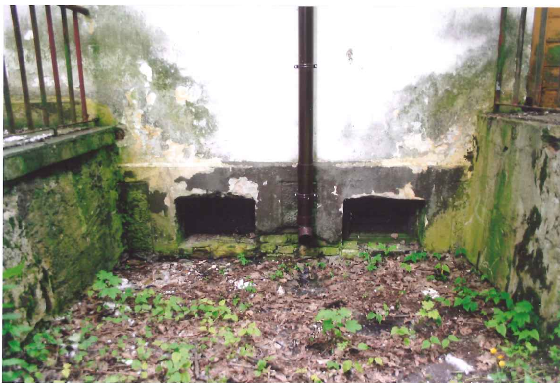
FOT. 16 I 17 DWÓR W GRABOWIE ELEWACJA PÓŁNOCNA WADLIWIE ZAMONTOWANE ODPLYWY RUR SPUSTOWYCH
