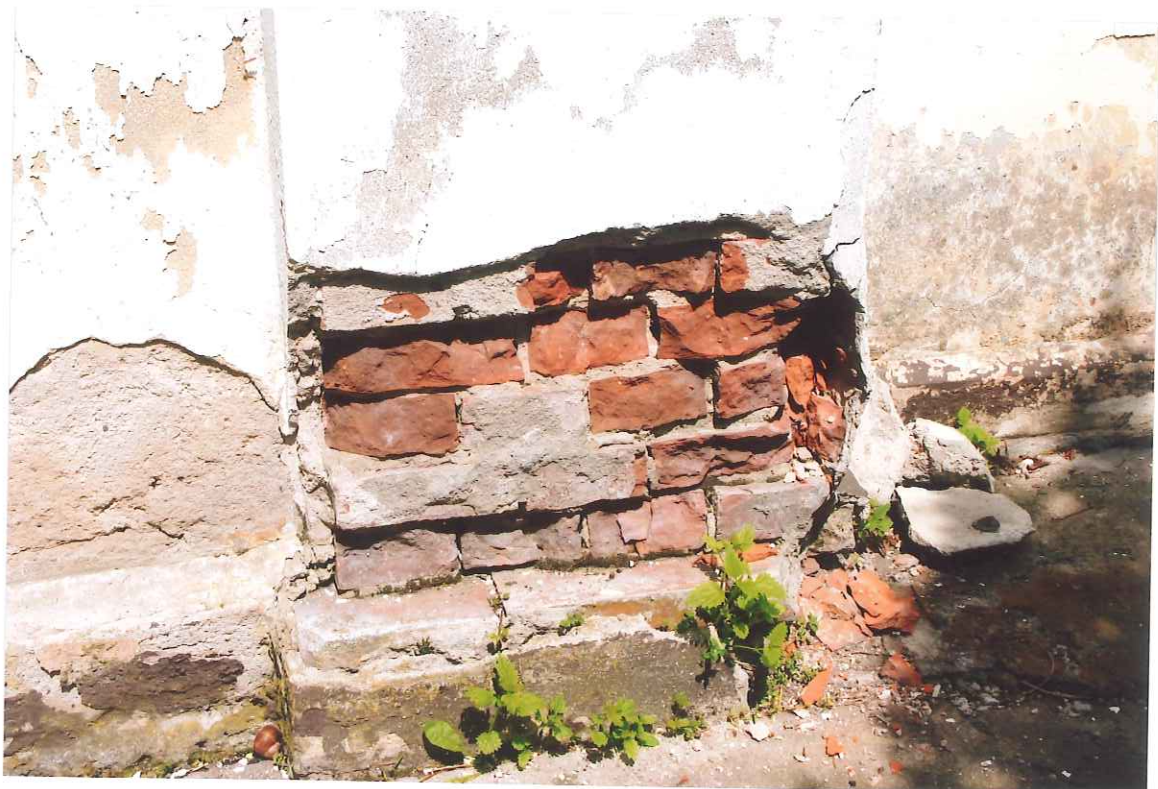
FOT. 13 DWÓR W GRABOWIE SKRZYDŁO ZACHODNIE, ZNISZCZENIA CEGIEŁ SPOWODOWANE USZCZELNIENIEM - CEMENTOWY COKÓŁ I OPASKA
