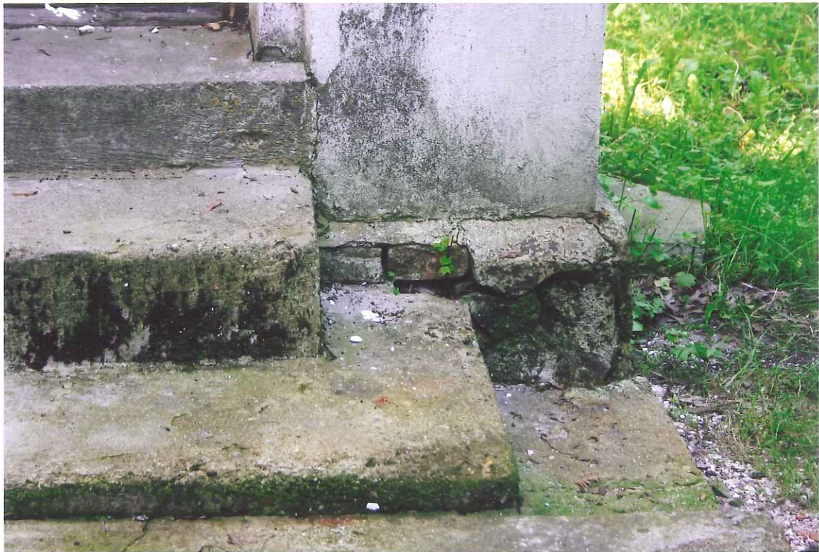
FOT. 12 DWÓR W GRABOWIE SKRZYDŁO WSCHODNIE. ELEWACJI POŁUDNIOWEJ , BETONOWA OPASKA
