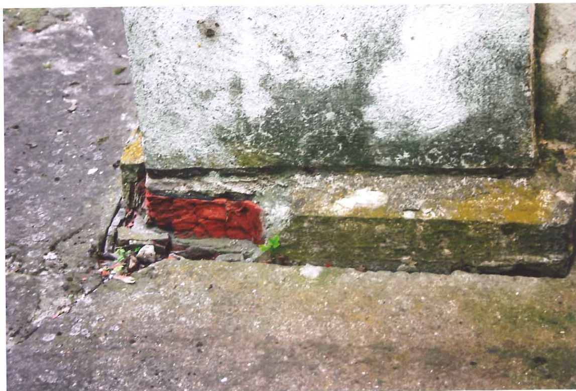
FOT. 11 DWÓR W GRABOWIE SKRZYDŁO WSCHODNIE, ZNISZCZENIA CEGIEŁSPOWODOWANE USZCZELNIENIEM - CEMENTOWY COKÓŁ I OPASKA
