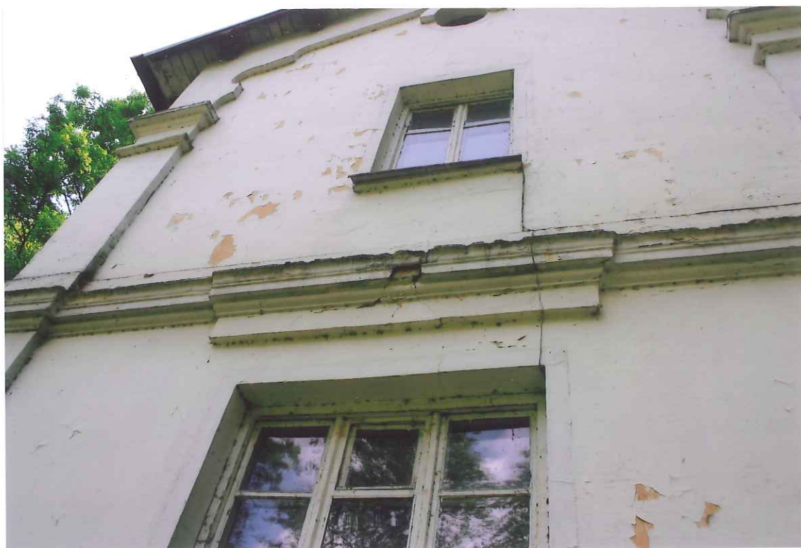
FOT. 22 , 23 DWÓR W GRABOWIE , SKRZYDŁO WSCHODNIE, USZKODZONE GZYMSY
