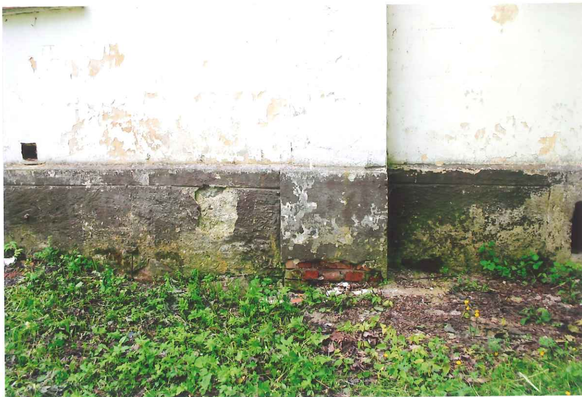
FOT. 18 I 19 DWÓR W GRABOWIE ELEWACJA PÓŁNOCNA, SKRZYDŁO WSCHODNIE, COKÓŁ NA DOLE WIDOCZNE ŚLADY ORYGINALNEGO TYNKU COKOŁU
