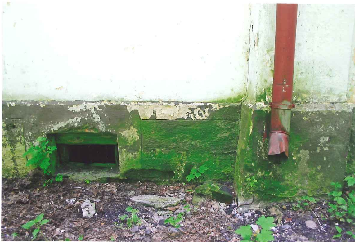
FOT. 16 I 17 DWÓR W GRABOWIE ELEWACJA PÓŁNOCNA WADLIWIE ZAMONTOWANE ODPLYWY RUR SPUSTOWYCH
