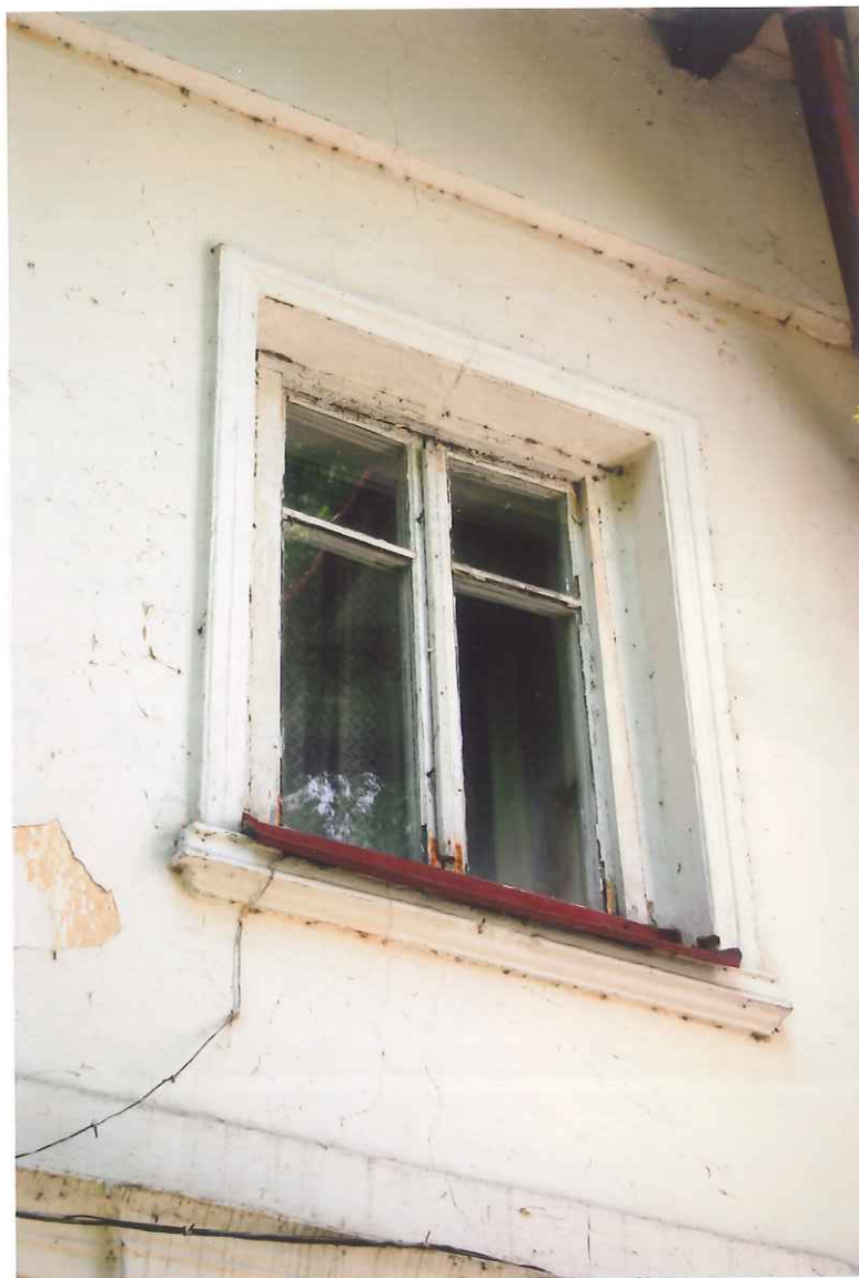
FOT. 26 DWÓR W GRABOWIE , ELEWACJA WSCHODNIA, OKNO Z ZACHOWANĄ OPASKĄ FOT. 27 DWÓR W GRABOWIE SKRZYDŁOZACHODNIE, WTÓRNA OPASKA CEMENTOWA
