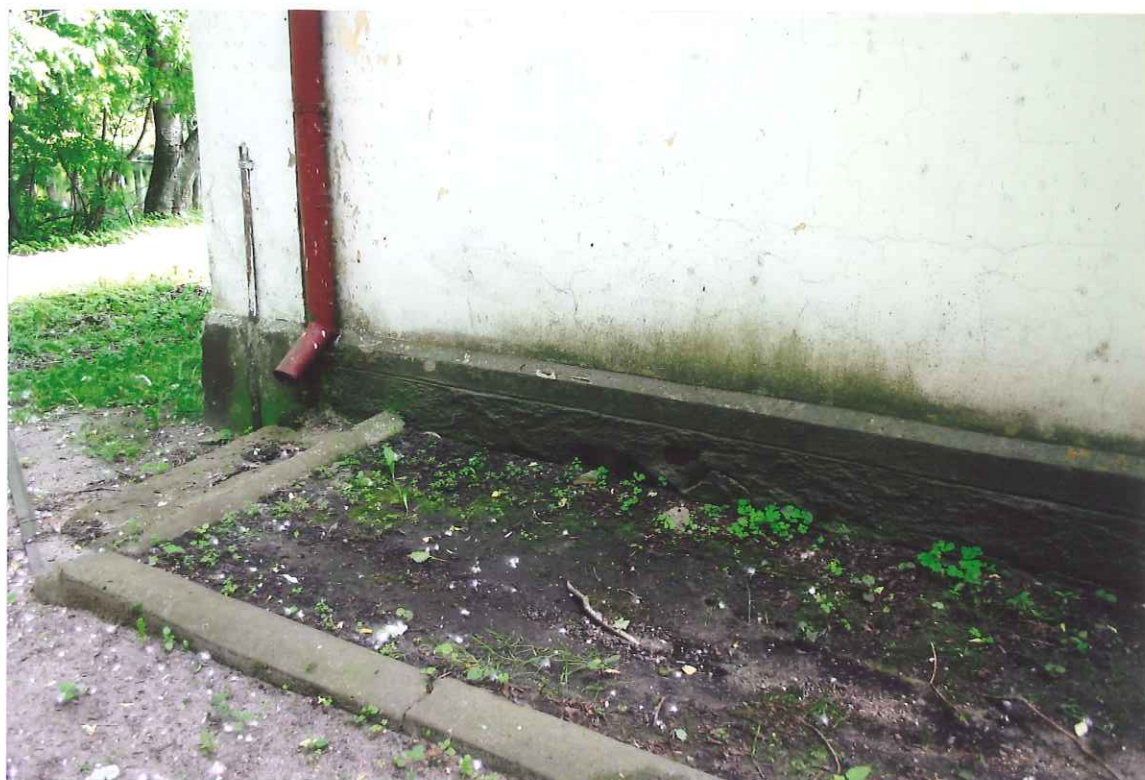
FOT. 15 DWÓR W GRABOWIE SKRZYDŁO ZACHODNIE, WADLIWIE ZAMONTOWANE ODPLYWY RUR SPUSTOWYCH
