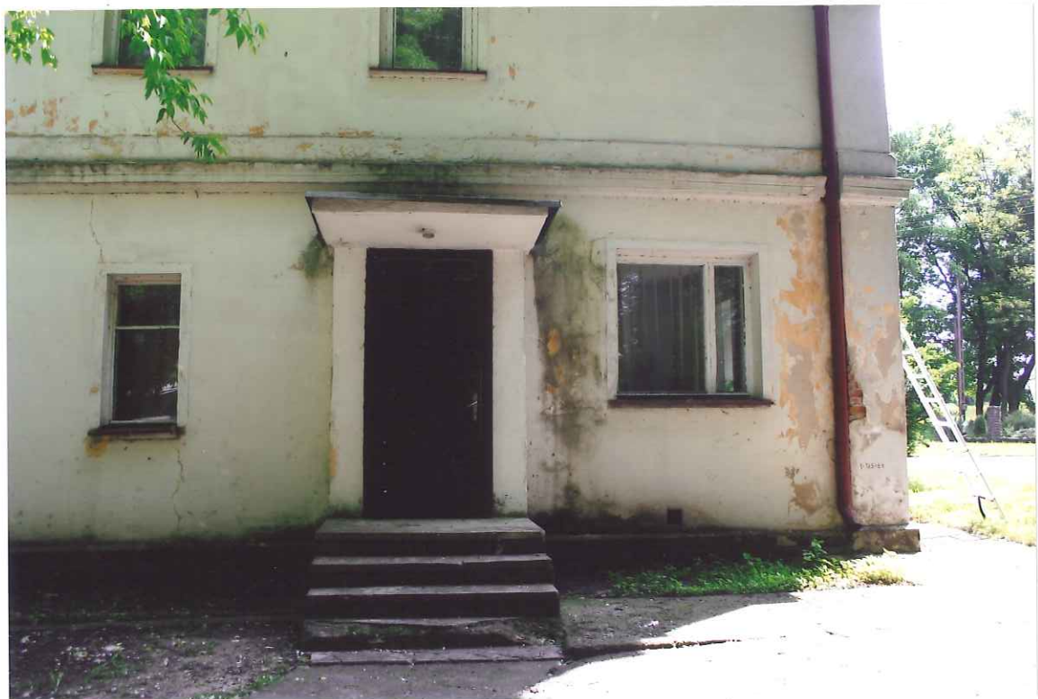
FOT. 6 DWÓR W GRABOWIE. ELEWACJA POŁUDNIOWA, ŚLADY ZAWILGOCENÍ FOT. 7 DWÓR W GRABOWIE ELEWACJA ZACHODNIA, ZNISZCZENIA TYNKU I ŚLADY ZAWILGOCENÍ
