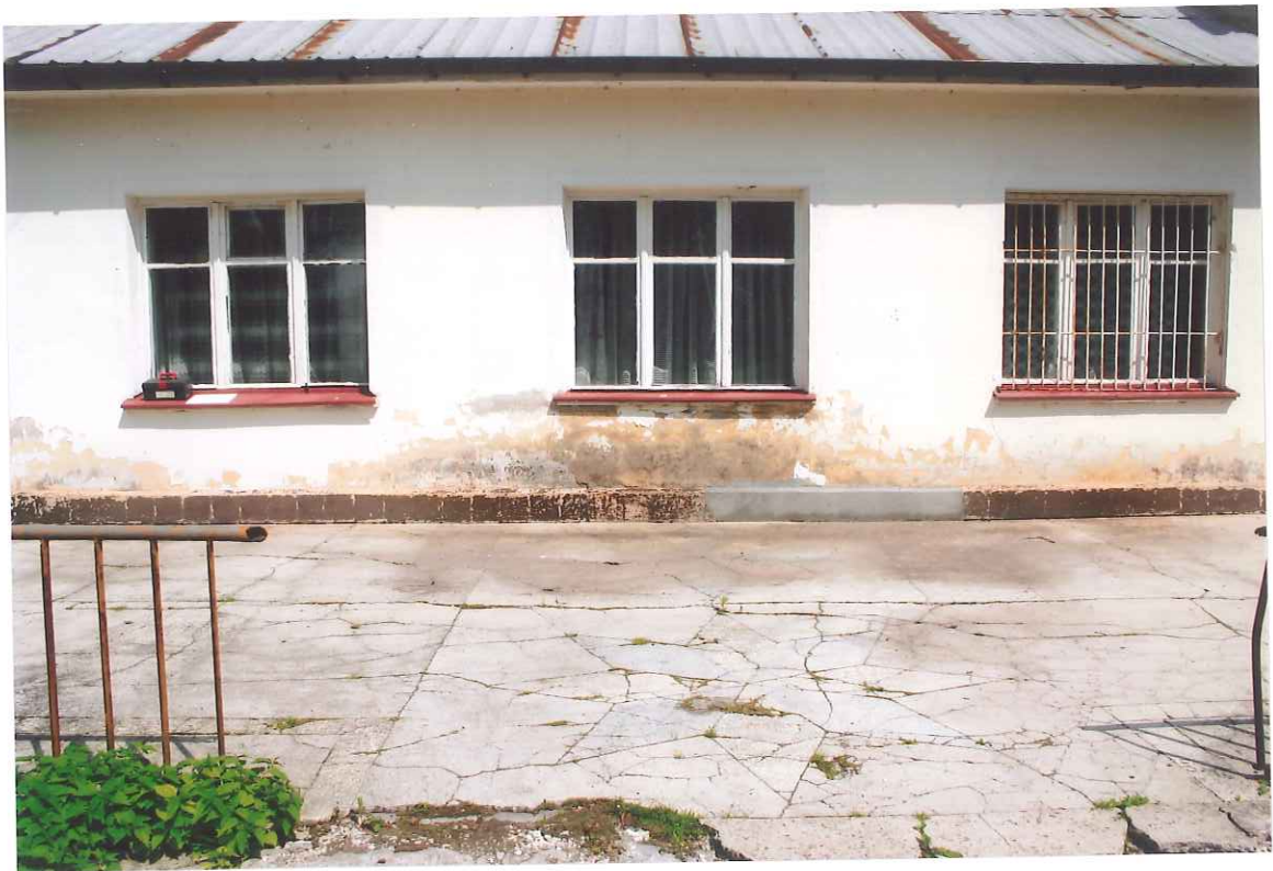
FOT. 6 DWÓR W GRABOWIE. ELEWACJA POŁUDNIOWA, ŚLADY ZAWILGOCENÍ FOT. 7 DWÓR W GRABOWIE ELEWACJA ZACHODNIA, ZNISZCZENIA TYNKU I ŚLADY ZAWILGOCENÍ
