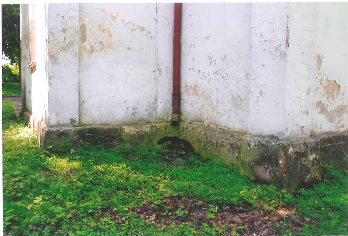
FOT. 14 DWÓR W GRABOWIE SKRZYDŁO WSCHODNIE. ELEWACJI PÓŁNOCNEJ WADLIWIE ZAMONTOWANE ODPLYWY RUR SPUSTOWYCH
