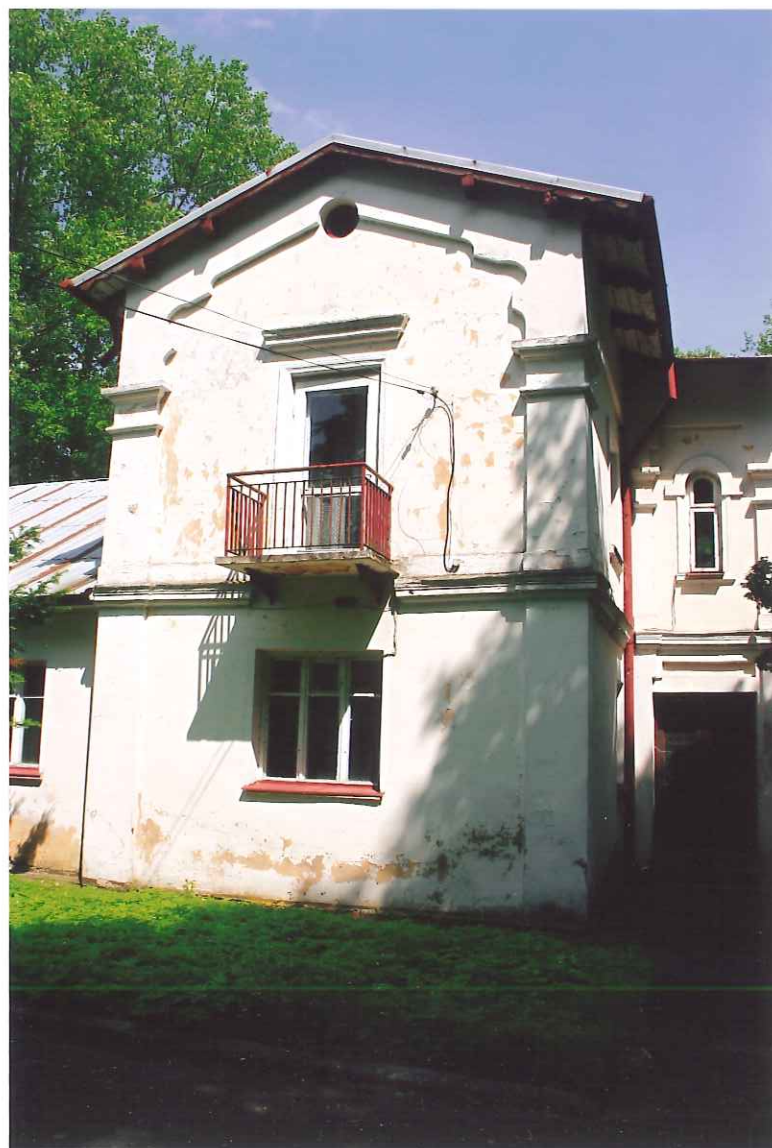
FOT. 4 DWÓR W GRABOWIE. ELEWACJA ZACHODNIA FOT. 5 DWÓR W GRABOWIE SKRZYDŁO WSCHODNIE ELEWACJI POŁUDNIOWEJ WIDOCZNE NA ELEWACJI ŚLADY PODCIĄGANIA WILGOCI
