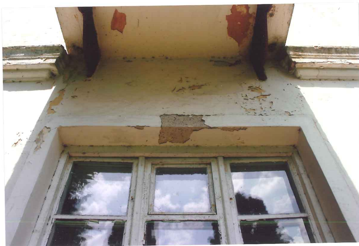
FOT. 26 DWÓR W GRABOWIE , ELEWACJA WSCHODNIA, OKNO Z ZACHOWANĄ OPASKĄ FOT. 27 DWÓR W GRABOWIE SKRZYDŁOZACHODNIE, WTÓRNA OPASKA CEMENTOWA
