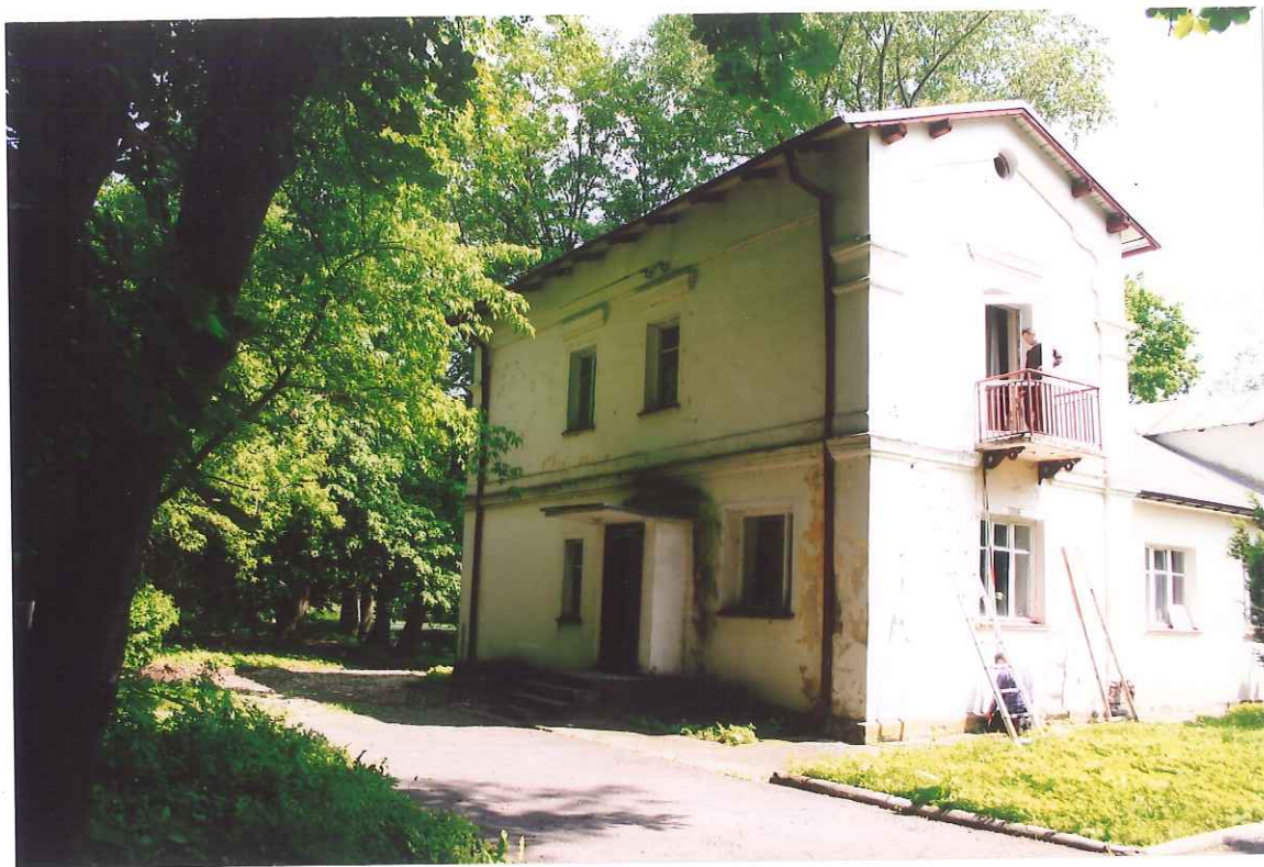
FOT. 4 DWÓR W GRABOWIE. ELEWACJA ZACHODNIA FOT. 5 DWÓR W GRABOWIE SKRZYDŁO WSCHODNIE ELEWACJI POŁUDNIOWEJ WIDOCZNE NA ELEWACJI ŚLADY PODCIĄGANIA WILGOCI
