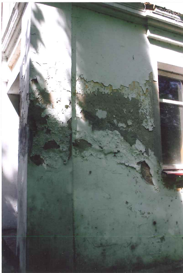
FOT. 9 DWÓR W GRABOWIE SKRZYDŁO WSCHODNIE, ZNISZCZENIA TYNKU I FARBY SPOWODOWANE ZAWILGOCENIEM, CEMENTOWE NAPRAWY
